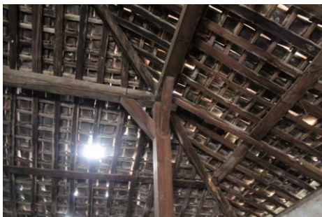
Gambar 7. Struktur atap pada bangunan joglo bucu Ponorogo
