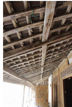
Gambar 9. Struktur atap pada bangunan rumah joglo bucu Ponorogo
