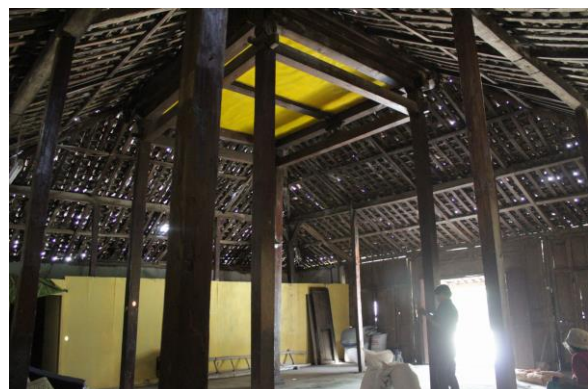
Gambar 3. Bentukan Struktur atap pada bangunan rumah joglo bucu Ponorogo
