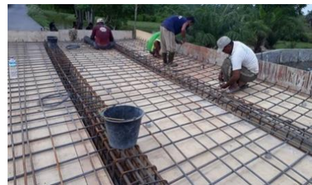
Gambar 11. Plat lantai beton
