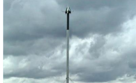
Gambar 19. Penangkal Petir Elektrostatik
