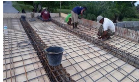
Gambar 11. Plat lantai beton
