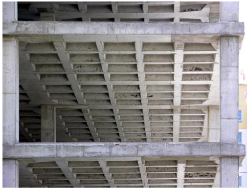
Gambar 5. Balok beton bertulang
