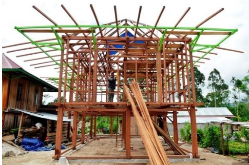
Gambar 10. Struktur bangunan panggung
