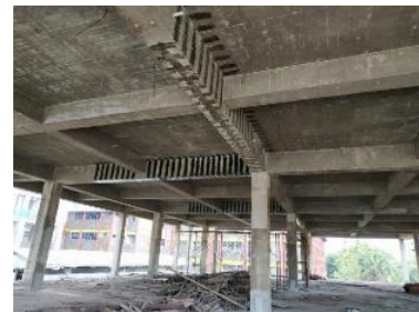
Gambar 11. Balok Beton Bertulang
