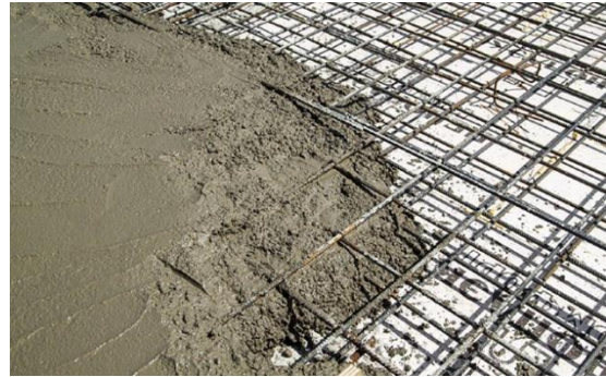
Gambar 7. Plat lantai beton bertulang
