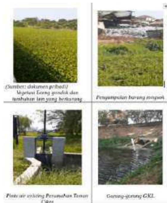
Gambar 3. Kondisi Infrastruktur dan
