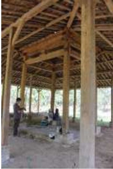
Gambar 11. Bentuk Struktur atap pada bangunan rumah joglo bucu Ponorogo
