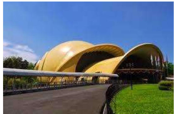
Gambar 19. Struktur Cangkang
