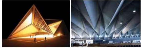
Gambar 18. Struktur Bidang Lipat
