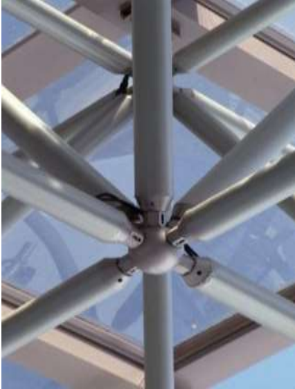
Gambar 16. Struktur Space
