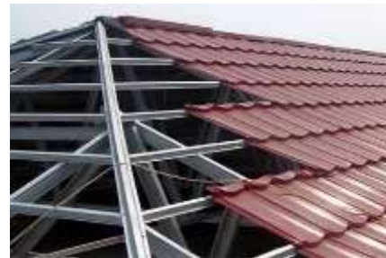
Gambar 47. Konstruksi Baja Ringan
