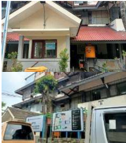
Gambar 3. Post Keamanan dan gedung Pengelola
