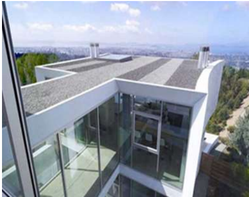
Gambar 18. Atap pelat beton
